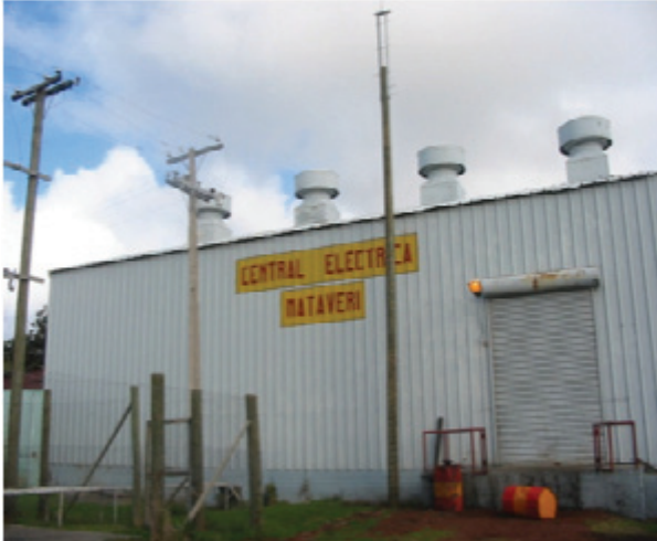
/ Central Eléctrica Mataveri (Nuñez 2006)
