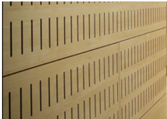
Resonador múltiple Helmholtz .Fuente imagen : www.soloarquitectura.com
