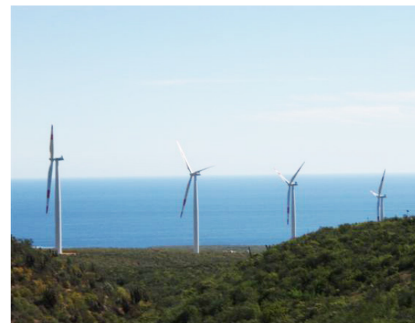
2.4 Parque Eólico de Canela I y II - Ubicado en la IV Región, con una capacidad de 80 MW de potencia.
