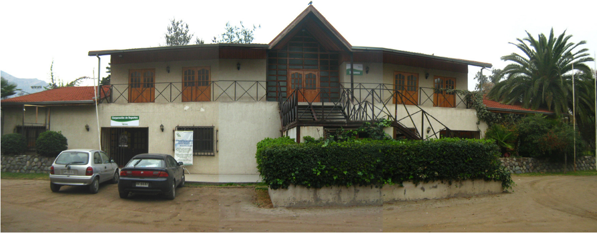
Fachada Norte, Casona de Oficinas, salas de reuniones y camarines de piscinas, acceso a oficinas
