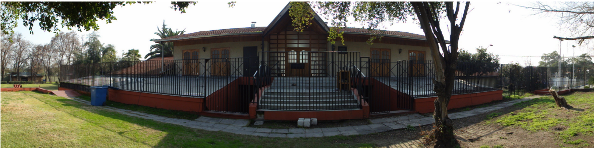
Fachada Sur de la Casona, acceso a camarines
