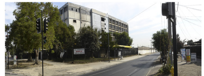
Fábrica de Nylon (Fabrica antigua inoperante pero en sus predios actualmente aun se fabrican productos Sumar)
