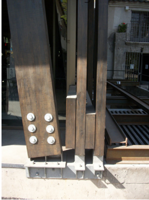
Unión Pilares Madera Laminada / hormigón
