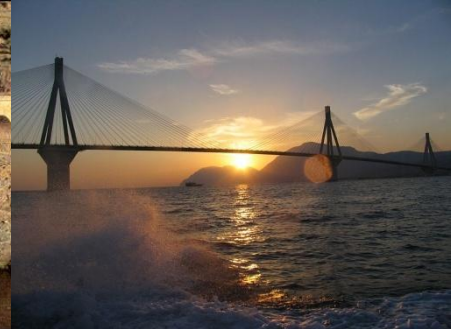
(2)(5) Puente Atirantado. Grecia
