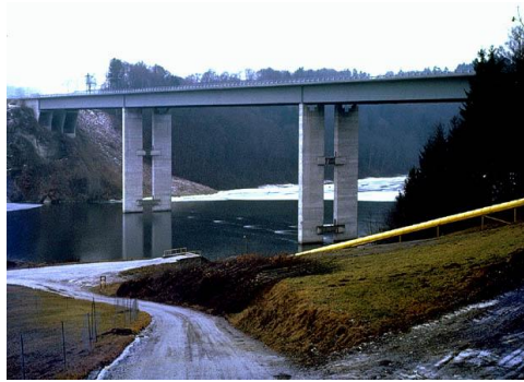
(1) Puente Viga. Lausanne, Suiza.
