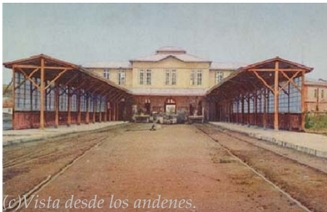
(b) Casa de Máquinas ubicada en zona costera del puerto.
