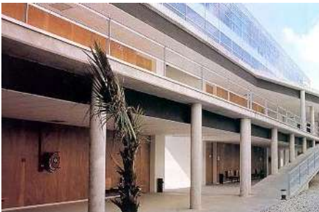
Escuela Politecnica de Alicante, patio interior
