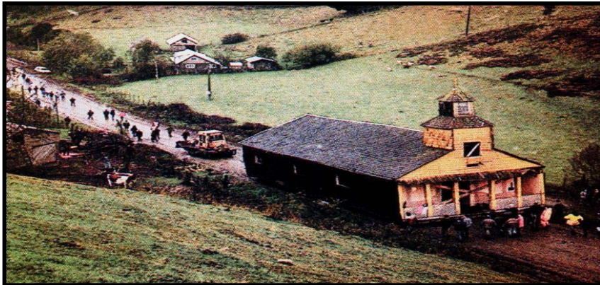
Foto N° 13.- Traslado de la Iglesia de Tey, desde la localidad de Tey a la localidad de Astilleros, por el camino que une Castro con Dalcahue.
