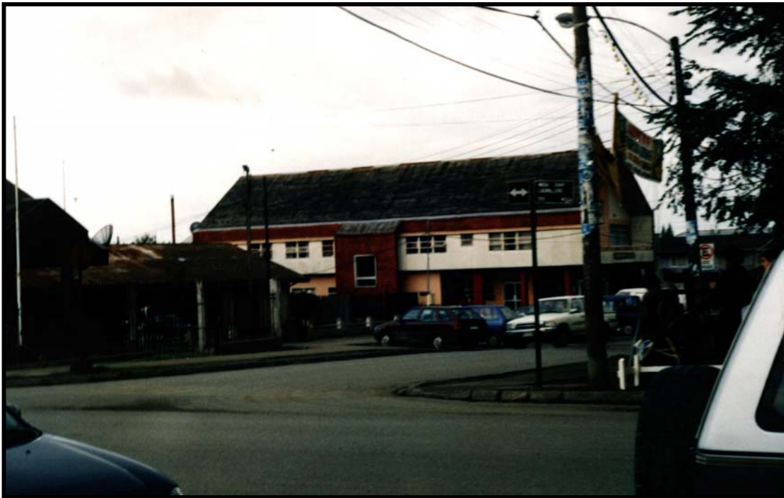
Foto N° 25. Edificio de la Municipalidad de Quellón, ubicado en el sector cívico de esta ciudad.
