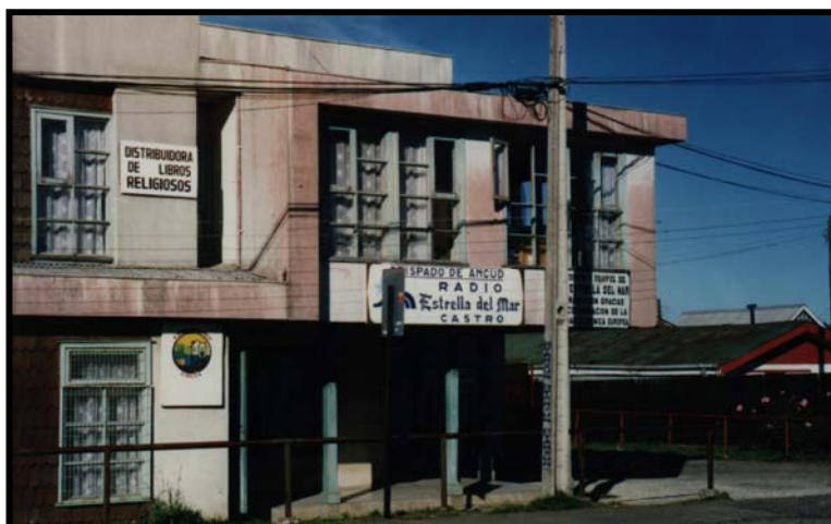
Foto N° 35. Radio Estrella del Mar. Ciudad de Castro
