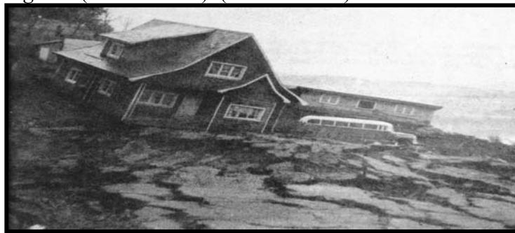
Foto N° 1. Casa chilota afectada del Terremoto 1960.
