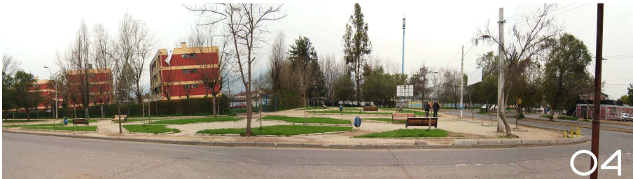
01/02/ 04 Vista del Parque inmediato al terreno y a La Av. José María Caro. 03 Vista del Parque en el Sector más próximo al terreno, tramo mas deteriorado.
