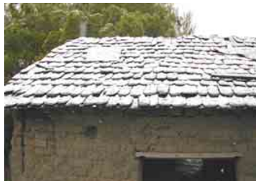
51 Construcciones en albañilería y adobe, de Puerto Tranquilo, Chile Chico y Puerto Ibáñez respectivamente
