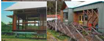
Referentes arquitectónicos, tipología constructiva de envaralado, procurando la continuidad del terreno natural, y la creación de un nuevo suelo artificial.
