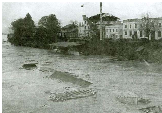
Antes y después del terremoto.
