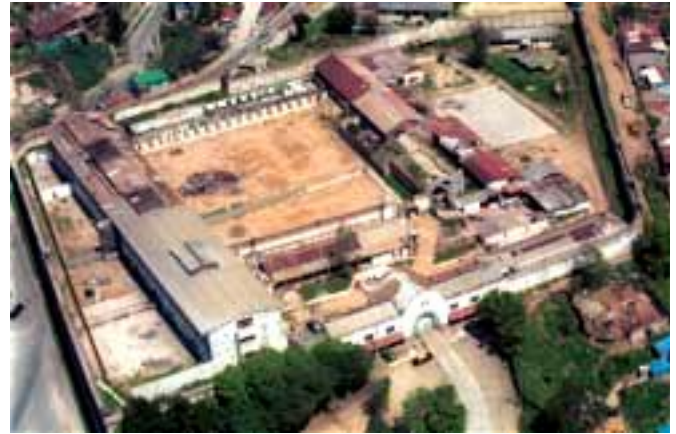
Imagen aérea de la cárcel de Valparaíso en pleno funcionamiento.
