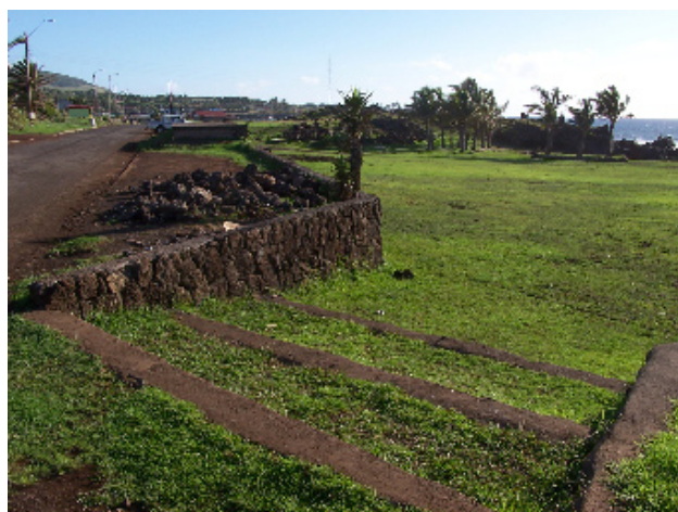
• Vista hacia el sur de terraza sur. Estacionamiento y baño público
