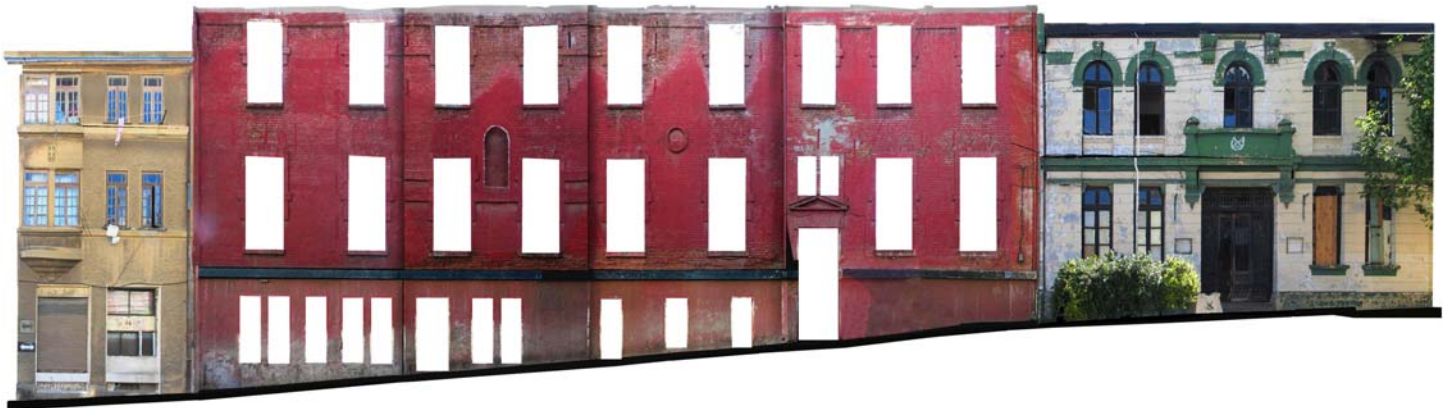
Fachada general de la manzana por calle Severín
