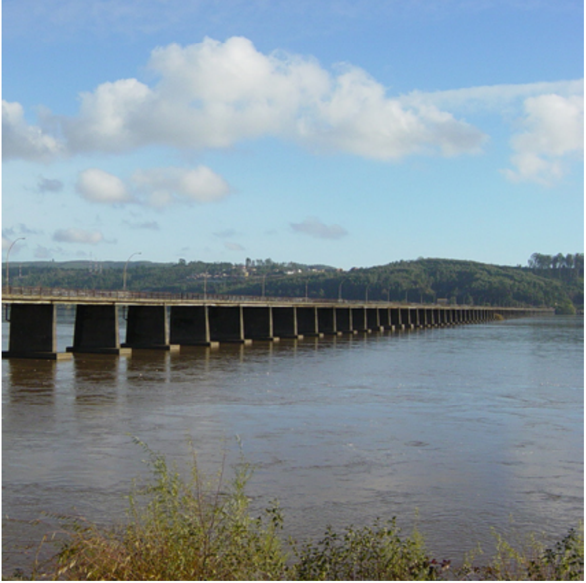
puente viejo Vista hacia cerro sector idahue
