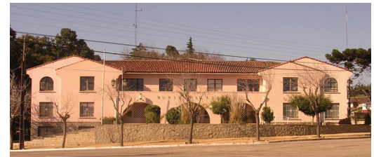
5.- Edificio Consistorial (Municipalidad)
