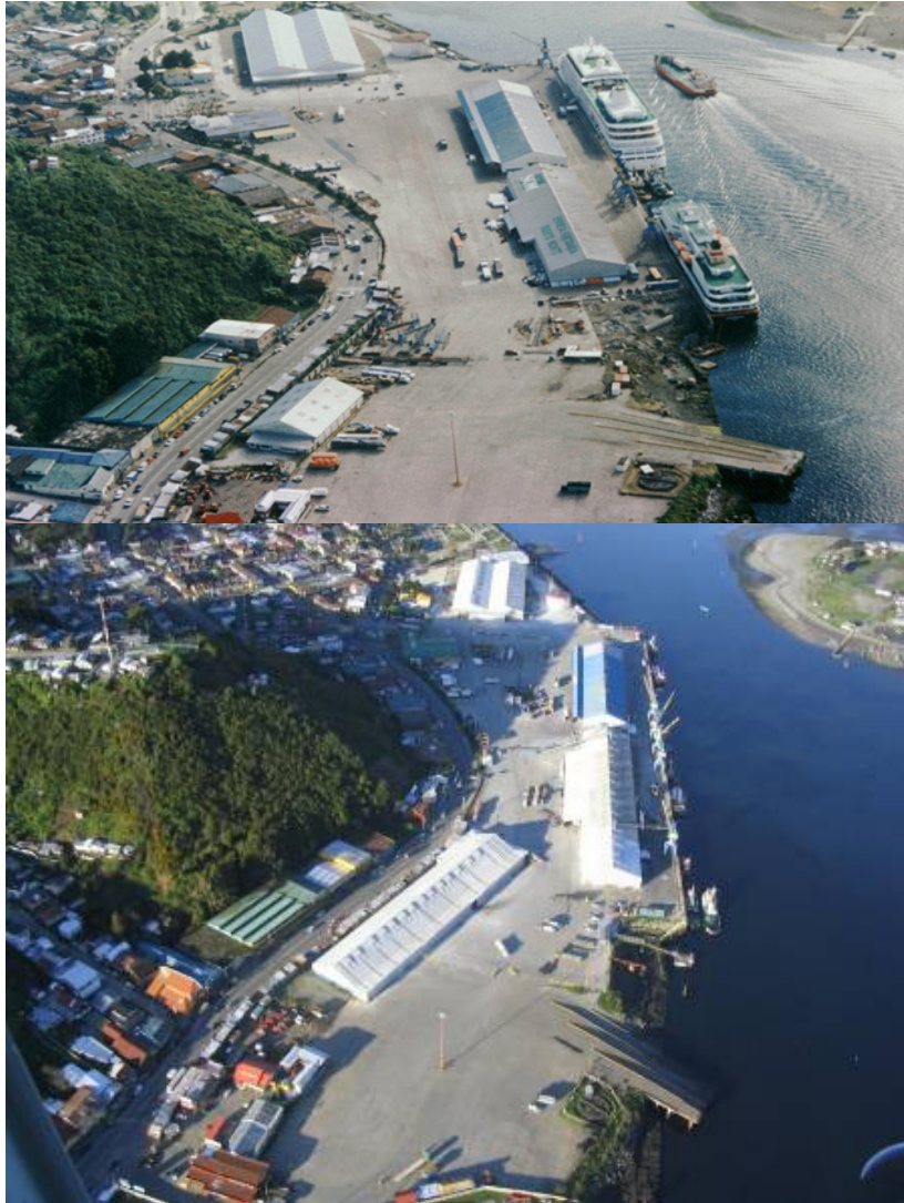
Puerto Marítimo de Puerto Montt, archivo digital
