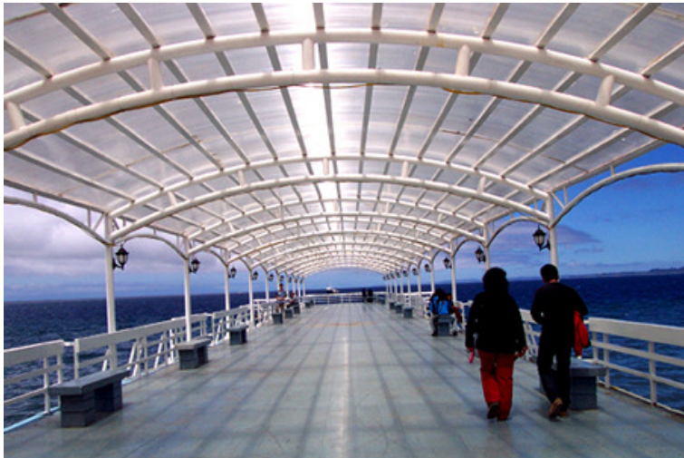
Vistas del muelle de Puerto Montt, archivo digital
