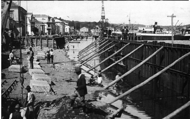
Trabajos Malecón Pto. Montt, archivo digital
