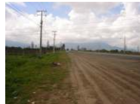
Foto 37: Vista de la vía de servicio, vereda norte
