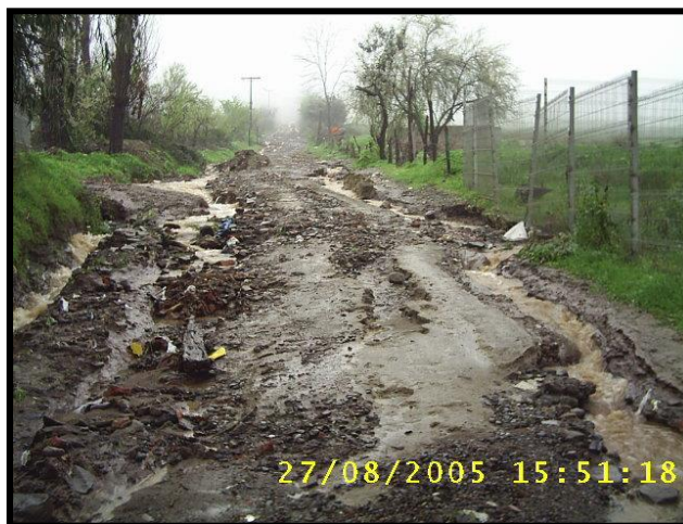
Fig.117: Caminos de tierra (Avenida El Peral) inundados (temporal 27 de Agosto 2005)
