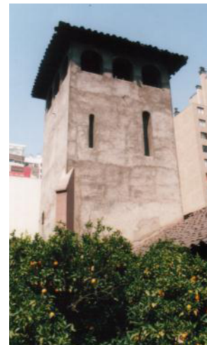
torre Casa de Los Diez. Luis Gómez
