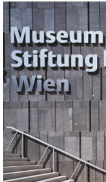
uso de placas de hormigón R. FREI, Götzis Bank (2003) Detail
