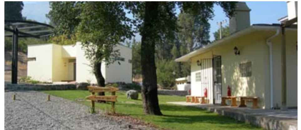
Acceso Parque Aguas de Ramón, La Reina 2007
