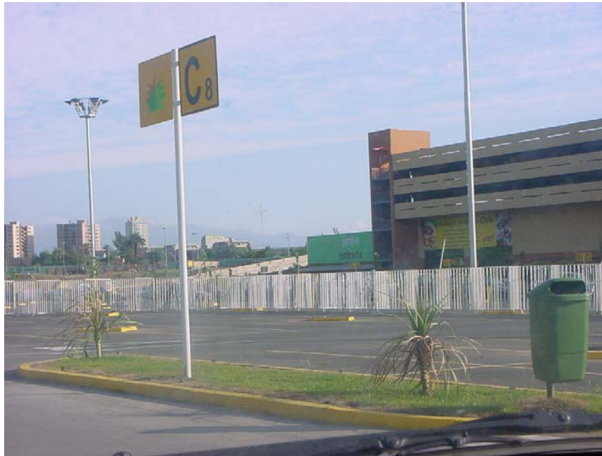
Imagen 7: Vista posterior del Mall Florida Center, en ella se aprecia parte del complejo de edificios Los Navegantes (vista hacia el sur). Estas estructuras hoy se reconocen ya como parte del paisaje del sector centro de La Florida.
