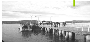
Acceso marítimo Muelle fiscal de Corral, vía de comunicación principal.
