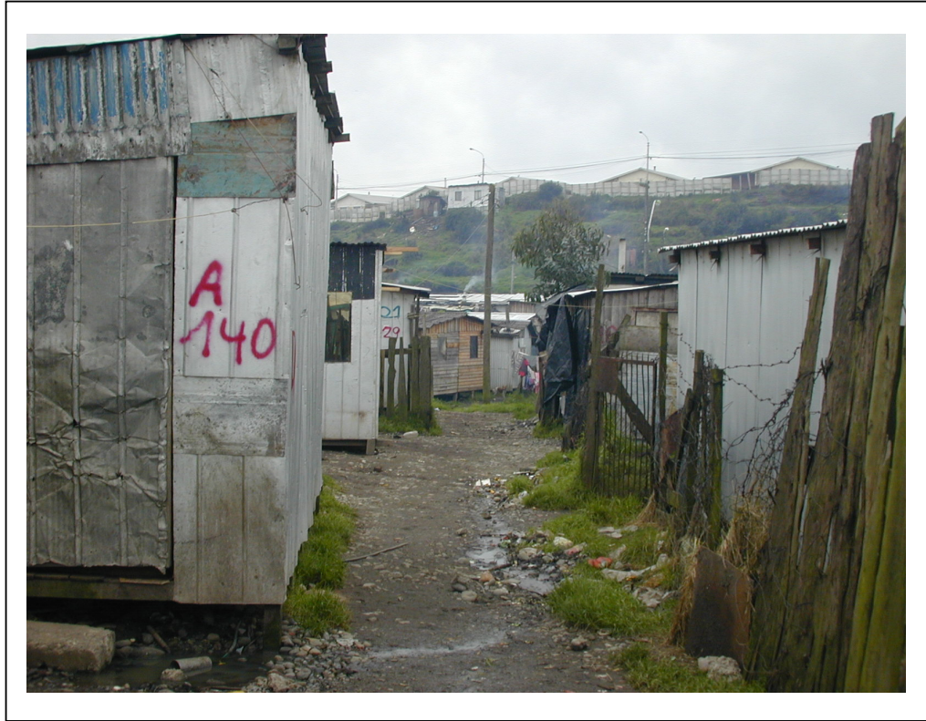
Fig. 45 Fotografía, vivienda de mala calidad en población de Puerto Montt (Mirasol).
