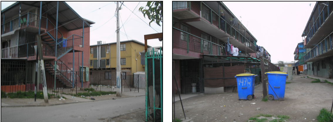
Fig. 49 Vista Conjunto Cordillera III
