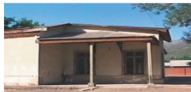
ESTACION SAN JOSÉ KM 24,2
