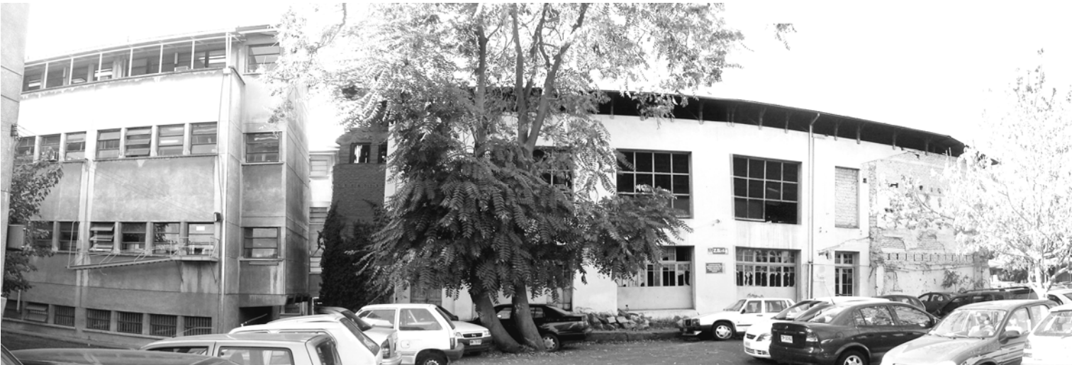
(Fot. 2) Edificio de lavandería del antiguo Hospital San Vicente de Paul, actualmente en abandono. Al costado izquierdo, la Facultad de Medicina de Juan Martínez .
