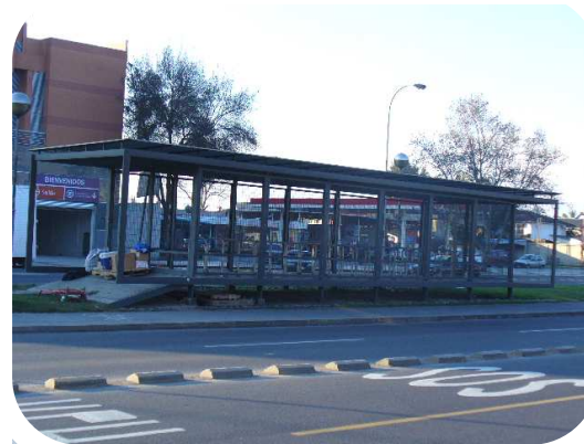
Estacionamiento seguro abandonado, estación metro las rejas. dispuesto por la municipalidad de Santiago, posee capacidad para 25 bicicletas
