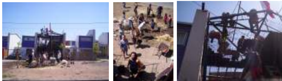
Fuente Imagenes: Archivo Propio. 1º Encuentro de Construcción en Tierra.
