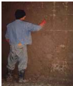
Obrero en proceso de aplicación manual del barro
