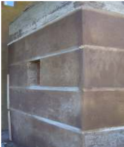
Proceso de construcción un muro de tapial armado en Obra "Casa Fredes", Lo Cañas (arriba) Construcción de muro de tapial armado (abajo) Detalle de vano y de terminación de muro de tapial armado
