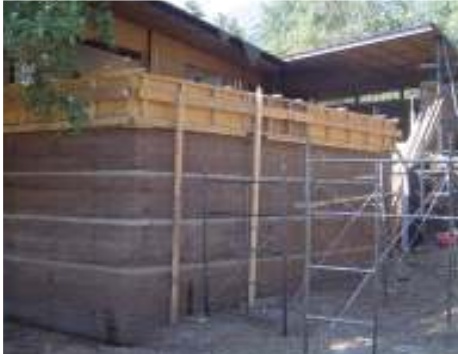
Proceso de construcción un muro de tapial armado en Obra "Casa Fredes", Lo Cañas (arriba) Construcción de muro de tapial armado (abajo) Detalle de vano y de terminación de muro de tapial armado
