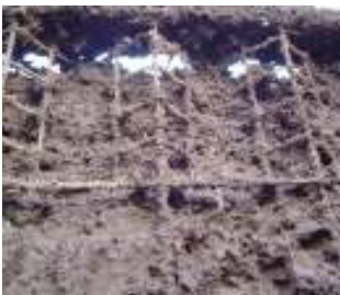
Sistema Constructivo Tecnobarro revestido con mezcla de tierra paja
