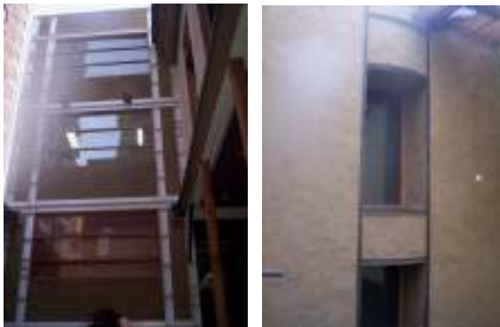
Facultad de Teatro. Universidad de Las Americas. Sistema Constructivo Tecnobarro. Arqto. Marcelo Cortes.
