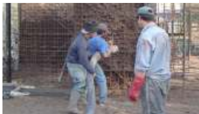
Utilización máquina shootcret para aplicación mecánica del barro
