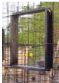
Detalle construcción en Sistema Constructivo Tecnobarro, detalle de unión, estructura de perfil de acero, con malla plegada electro soldada tipo acma y barra de acero tubular rigidizadora.
