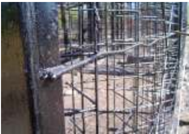
Detalle construcción en Sistema Constructivo Tecnobarro, detalle de unión, estructura de perfil de acero, con malla plegada electro soldada tipo acma y barra de acero tubular rigidizadora.
