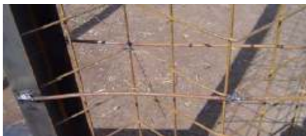
Detalle barra acero liso soldada a la malla
