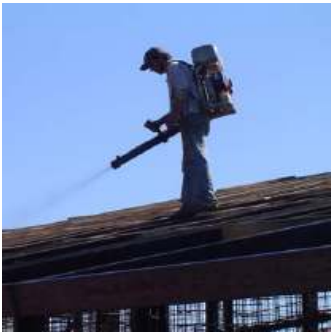
Aplicación emulsión asfáltica con máquina pulverizante.
