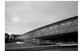
En las zonas donde no es necesario salvar grandes luces y el edificio se apoya directamente sobre el terreno se privilegia la limpieza espacial y la simpleza estructural, utilizando un sistema de marcos rígidos en base a pilares de hormigón armado y vigas de acero.
