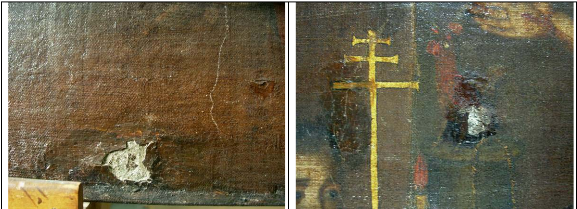
Desprendimientos en Parches Posteriores
