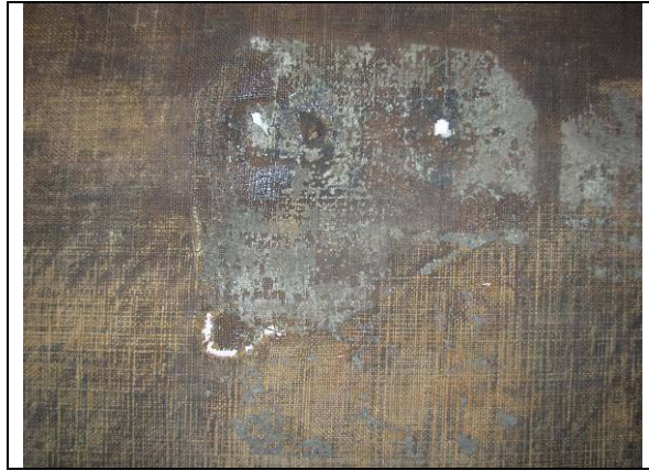
Detalle Limpieza mecánica
