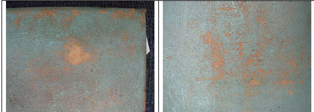
Faltante cielo esquina superior derecha
