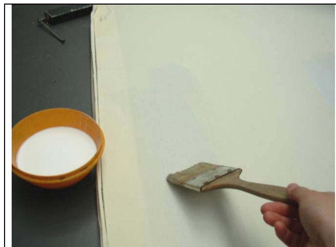
Impermeabilización con Mowilith
