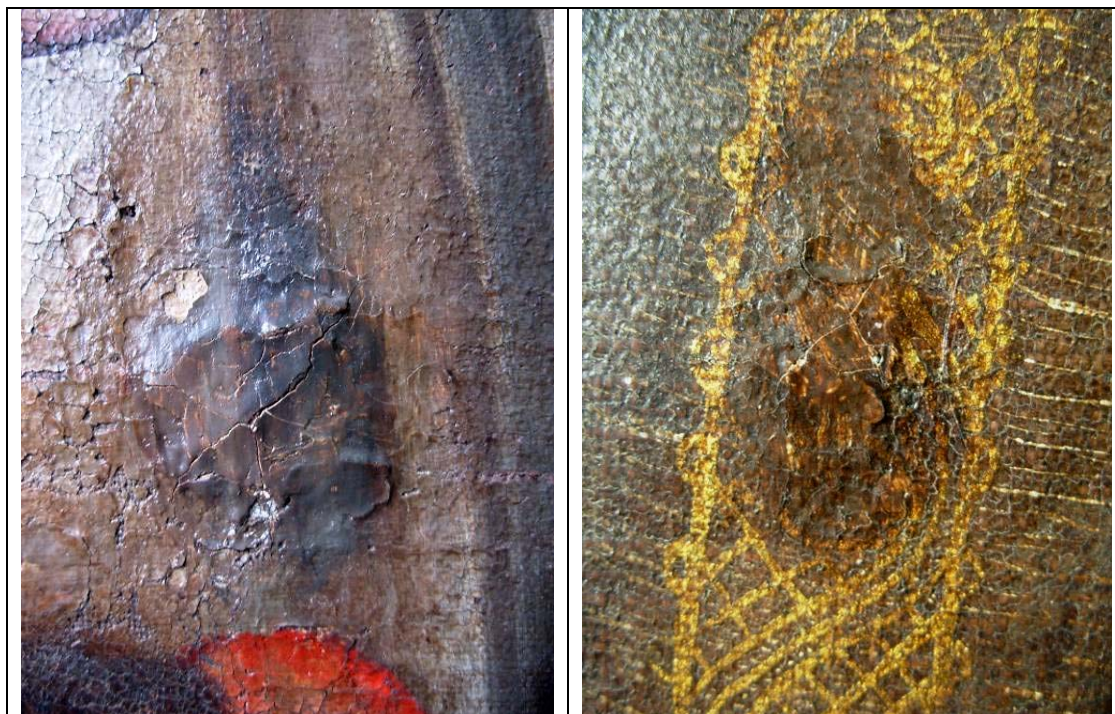
Grietas Parche Posterior
