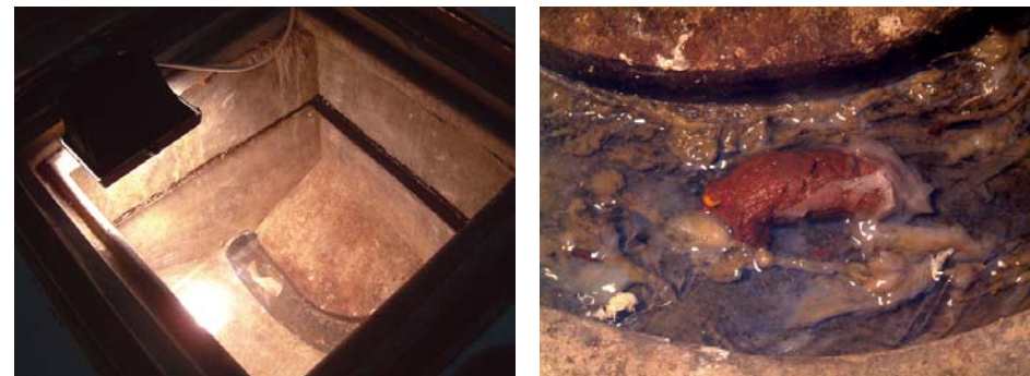
Fig. 14. Cámara sanitaria destapada. Fig. 15. Canal de ducto sanitario, detalle al de flujo de aguas servidas provenientes del baño del guardia del edificio.
