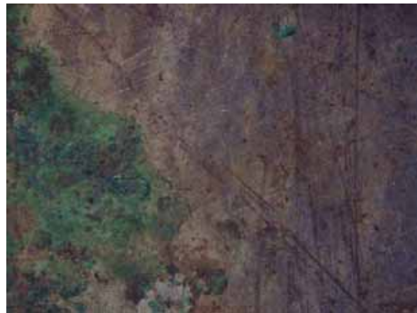
Macrofotografía detalle de área con corrosión carbonato (Neyra G.2009) Fig. N°28
