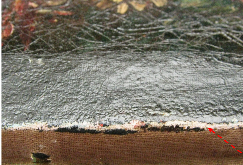
Fig. 15 Detalle de la capa de preparación, la cual es de color blanco, vista desde el borde de la pintura
