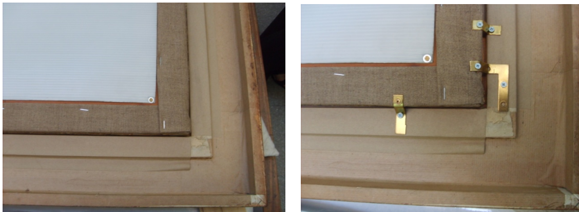
Fig. 77. Detalle de sistema de Montaje de la pintura.
