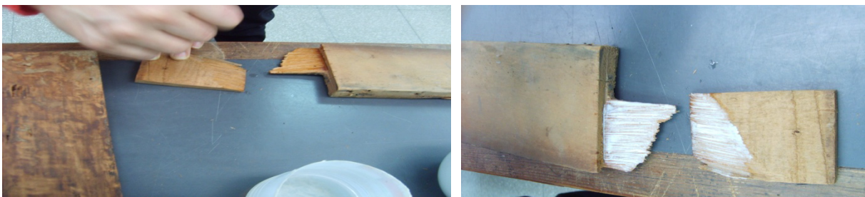
Fig.32. Izquierda limpieza de las superficies. Derecha. Cada parte con cola
