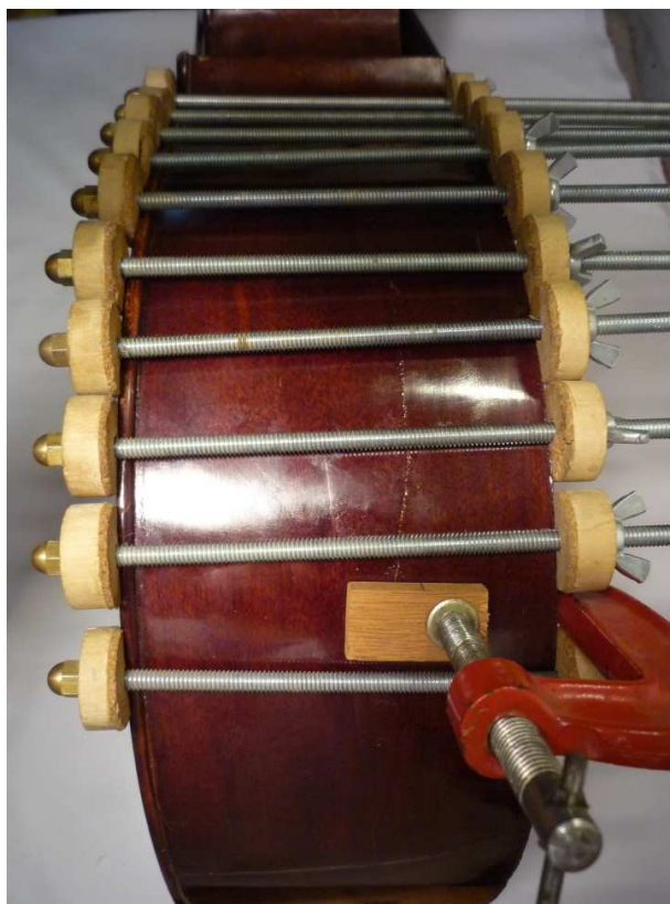
Fig 16: Proceso de prensa en el cierre y nivelación de la fisura.
