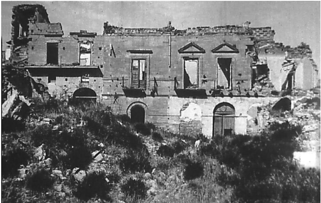
Fig. 28 Fachada en ruinas del Palazzo Di Lorenzo.
