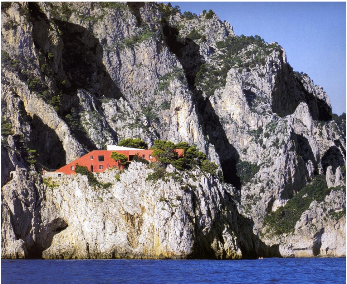
Fig. 24 Casa Malaparte. Capri, 1938. Vista de la casa a media costa, desde el mar.
