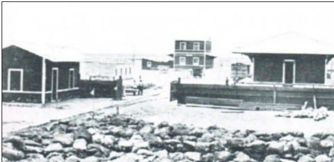
Ilustración 57. Estación Pintados de Ferrocarril Estatal.
