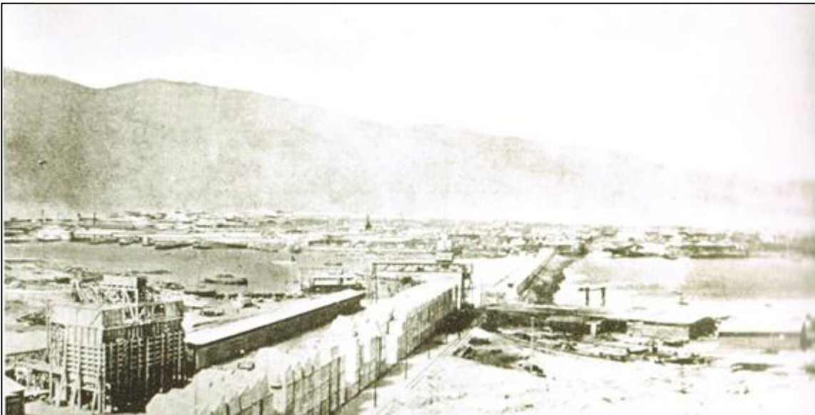
Fuente: Obras de relleno y construcción de las defensas, entre Iquique y el islote, década del 20. VÁSQUEZ, Juan "et all". Historia de Salitre y Mar. Iquique y la Pampa. p.50. [Fotografía].
