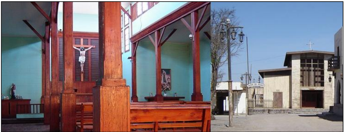
Ilustración 9. Visión interior y exterior de iglesia de Humberstone.
