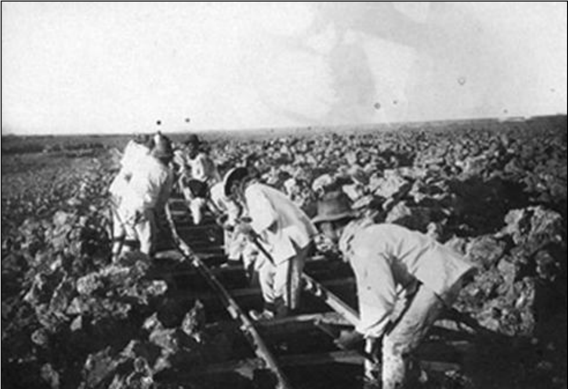
Ilustración 49. Obreros instalando un riel de ferrocarril en el desierto.
