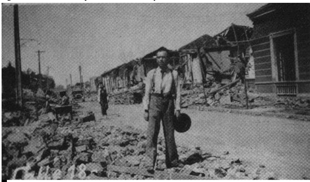
Imagen después del terremoto de Chillan en 1939. Terremoto de 7,8 grados en la escala de Richter. Después del terremoto el 24 de enero, de 3.526 inmuebles, 1.645 se desplomaron por completo. (35)
