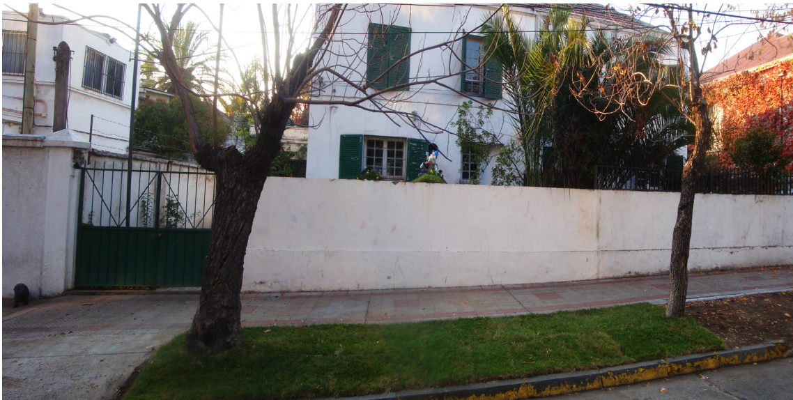
Vista exterior casa, posterior a la intervención.
