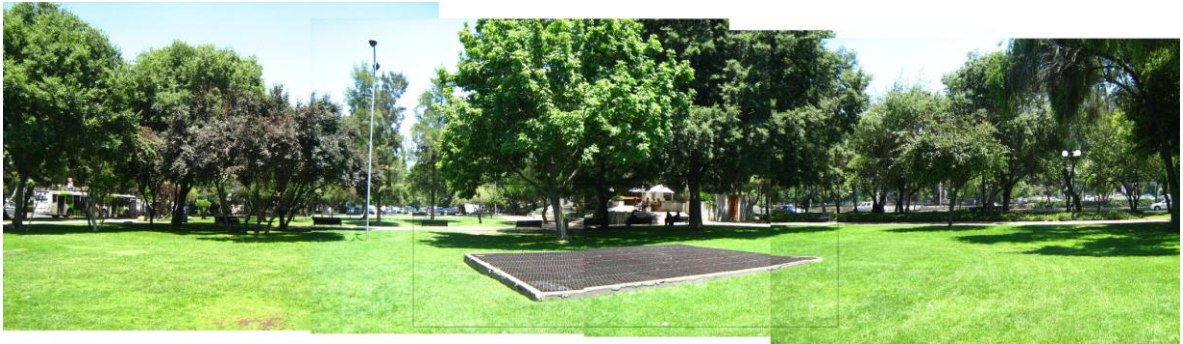
Salida de ventilación del Metro Salvador, a un costado del café literario.
