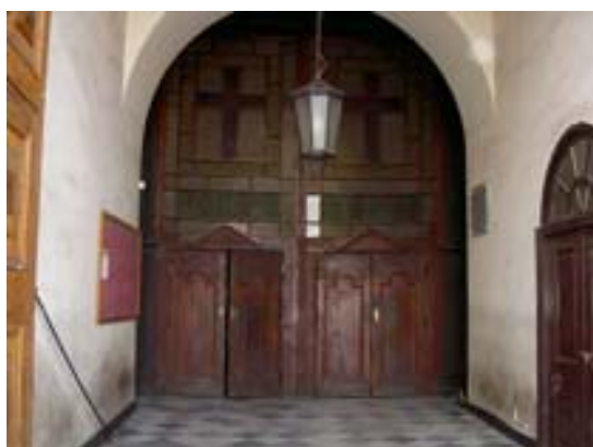
Lámina 25. Ante mampara de la puerta central. Fuente: Sandra González V.
