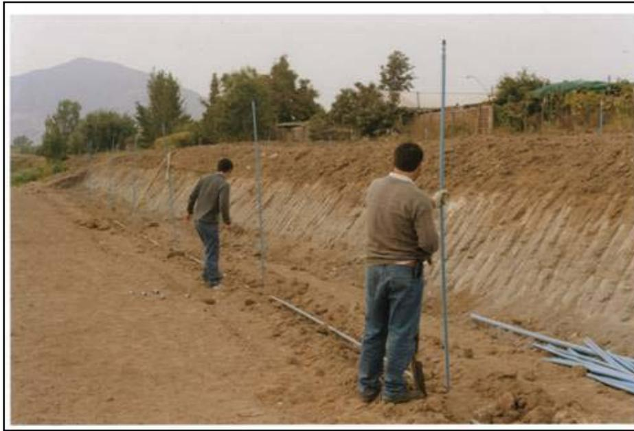
**Figura 4.** Instalación del sistema de riego, frente al talud 1:1.
