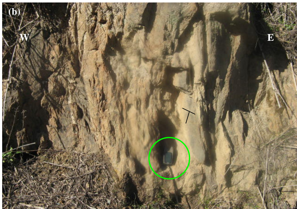
Figura 4.13: (a) Imagen tomada de Google Earth donde se observa la estructura 6 (Embalse Purísima). El círculo azul corresponde al lugar donde fue tomada la fotografía que se muestra en (b). (b) Fotografía mirando al NNE. Se observa escarpe “reciente” en roca intrusiva de rumbo N53^{\circ}W . El círculo verde encierra un receptor de GPS de unos 15 cm.
