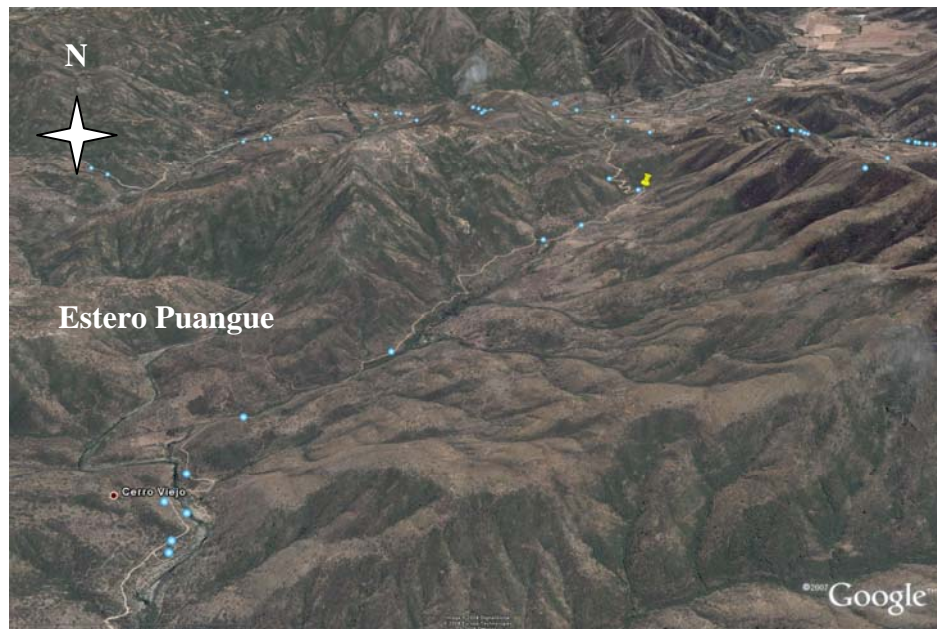
Figura 4.35: Imagen tomada de Google Earth en las cercanías del estero Puangue. En la imagen superior se muestran en rojo los tres tramos de la estructura Quebrada Grande (9.2, 9.3 y 9.4), que se pueden ver en la imagen inferior.
