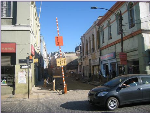
Ilustración 19: Trabajos en la Calle Serrano
