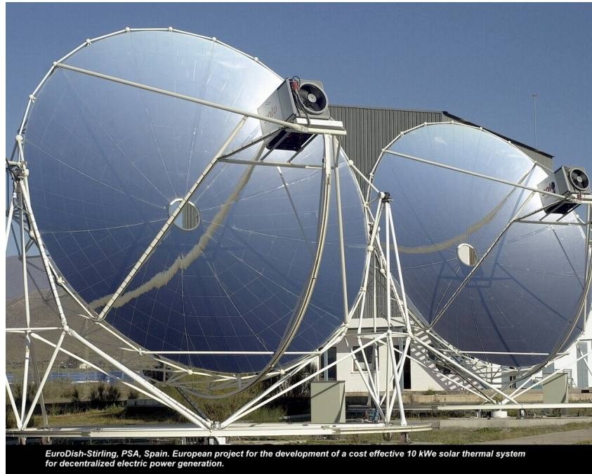
Figura 3.1: La foto corresponde a dos módulos EuroDish compuestos por un concentrador de diseño español y un motor SOLO V161
