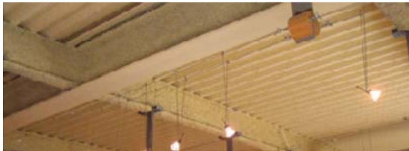
Figura 4.10: Losa de hormigón nervada.
