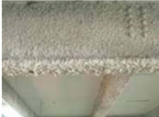
Figura 4.13: Viga protegida con estuco.
