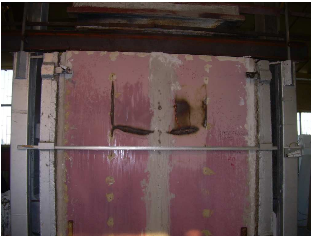
Figura N°22: Falla de tabique ensayo N°2.
