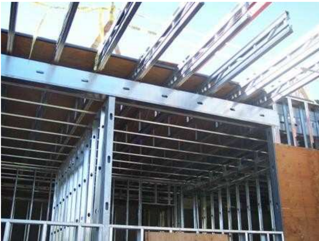
Figura N°2: Estructuración de piso metálico liviano
