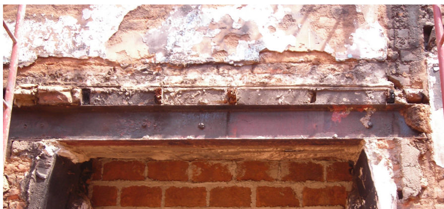
Figura 6.41 - Viga metálica de refuerzo en ventana
