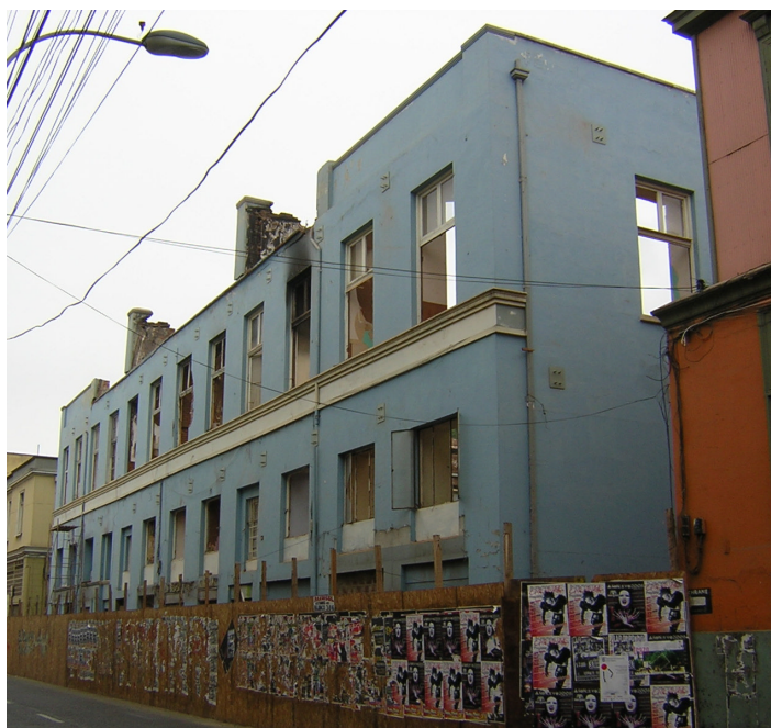
Figura 6.33 – Fachada a la calle Cochrane
