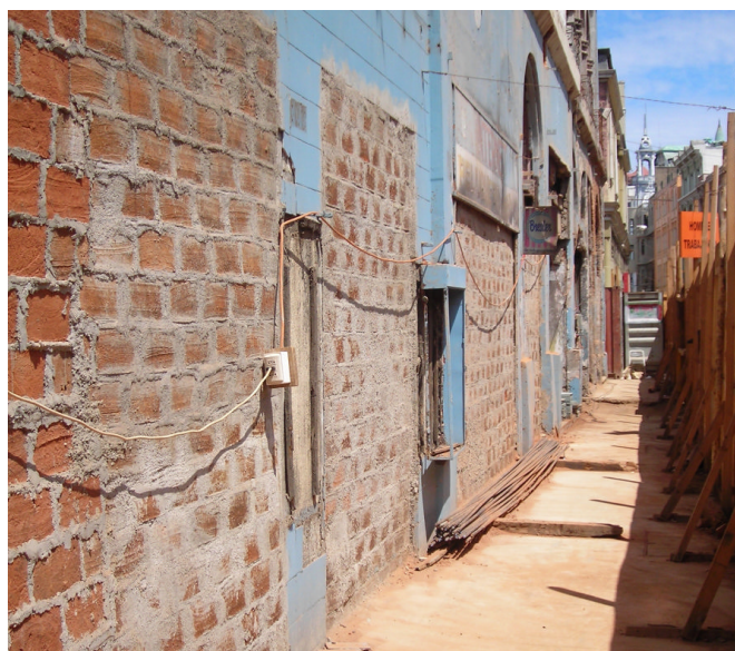
Figura 6.34 – Detalle de paños que sellan las aberturas de 1° piso
