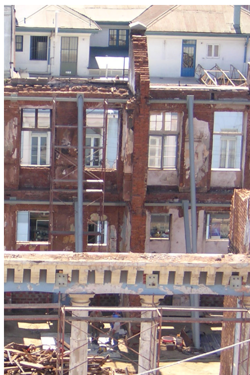
Figura 6.46 – Vista del sistema de apuntalamiento.
