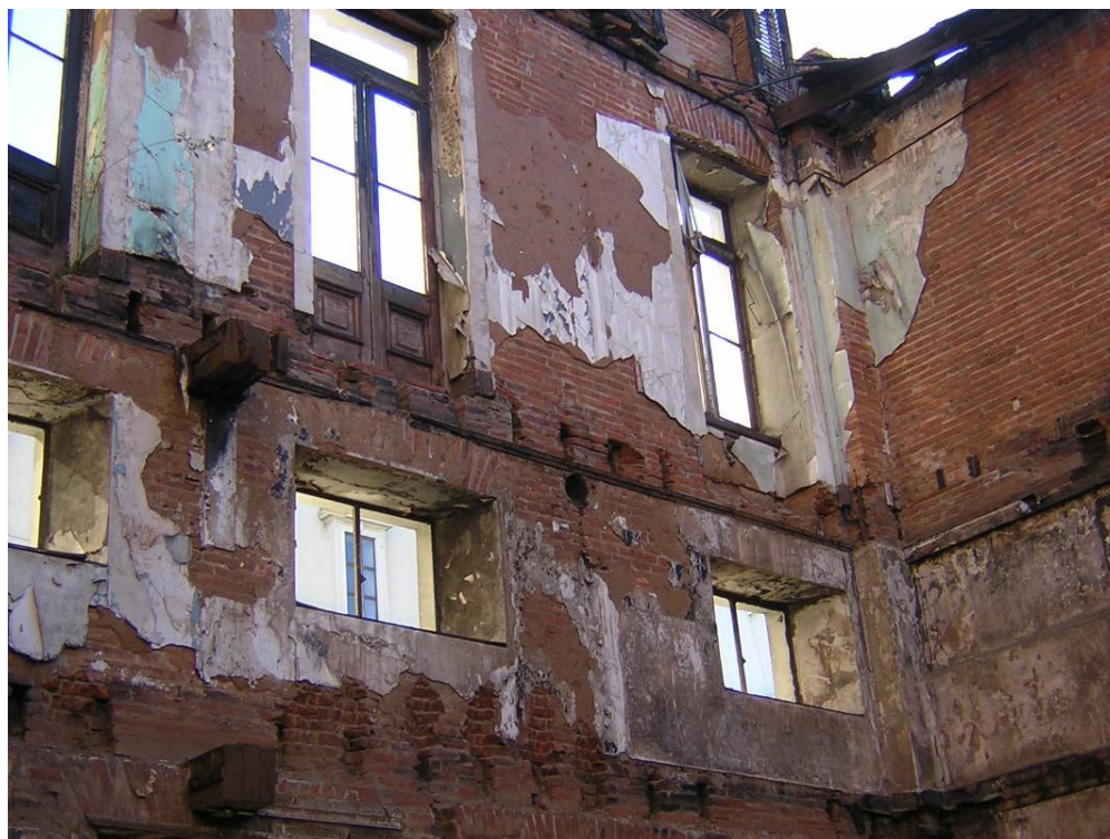
Figura 6.6 - Muros de albañilería sin refuerzo del primer, segundo y tercer piso
