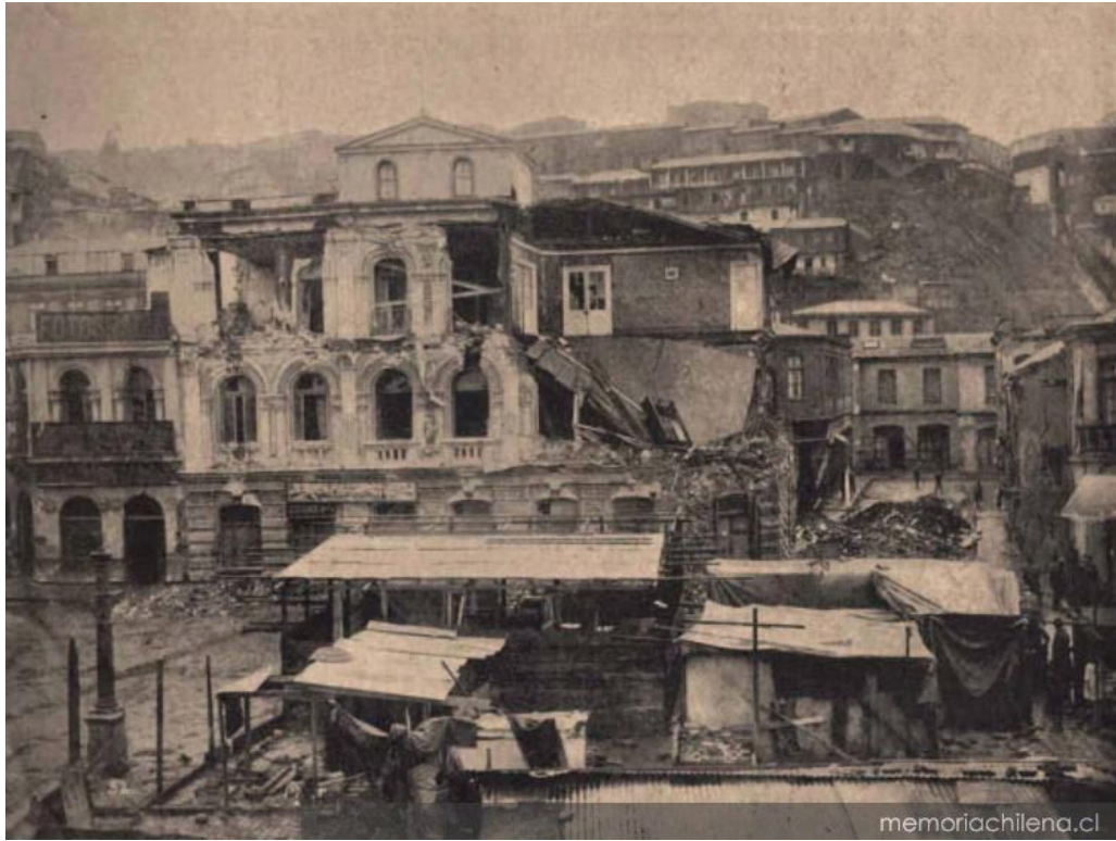
Figura 6.50 – Edificio esquina de la Plaza Echaurren después del terremoto de 1906
