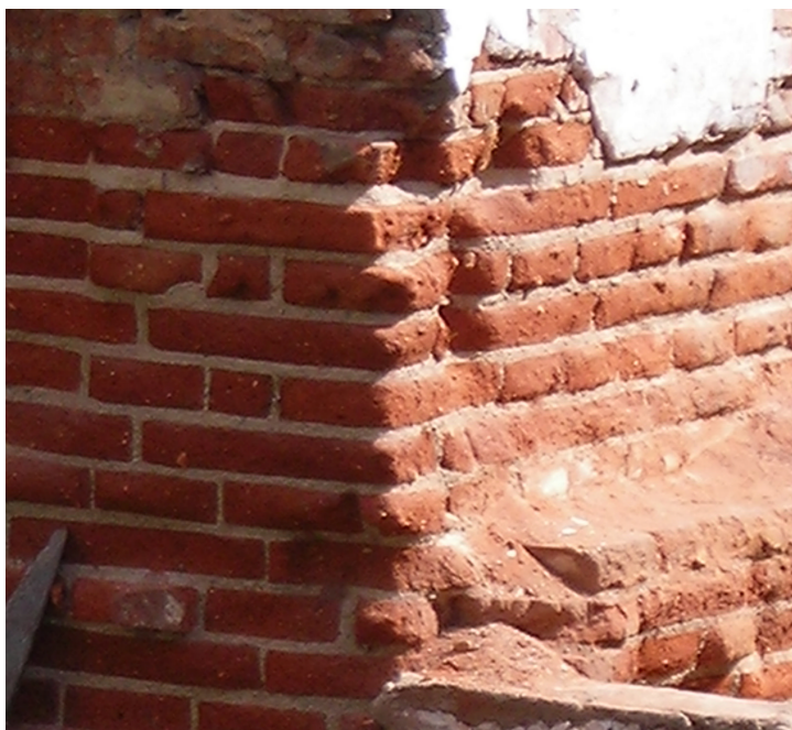
Figura 6.15 - Trabazón en el encuentro de muros
