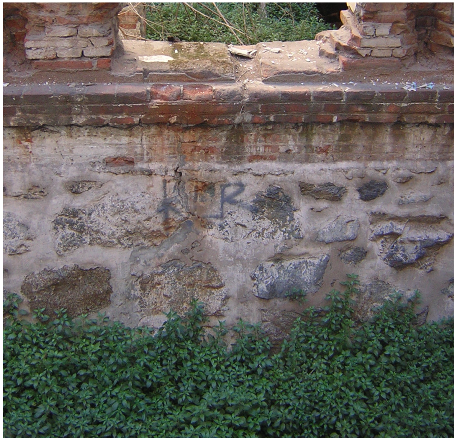
Figura 6.5 – Muro de albañilería de piedra del subterráneo
