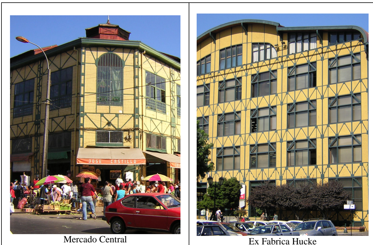
Figura 5.4 – Edificios reforzados con perfiles de acero.
