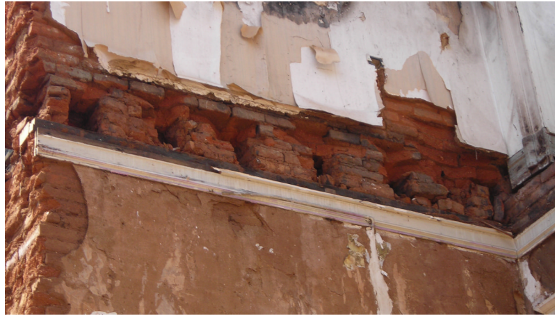
Figura 6.40 - Huecos en los muros de albañilería donde se apoyaba las vigas del sistema de piso.
