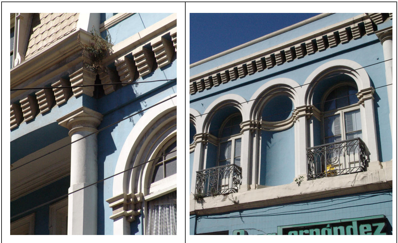
Figura 6.35 - Detalle de capitel de las columnas, antepechos y arcos del 2° piso por calle Serrano
