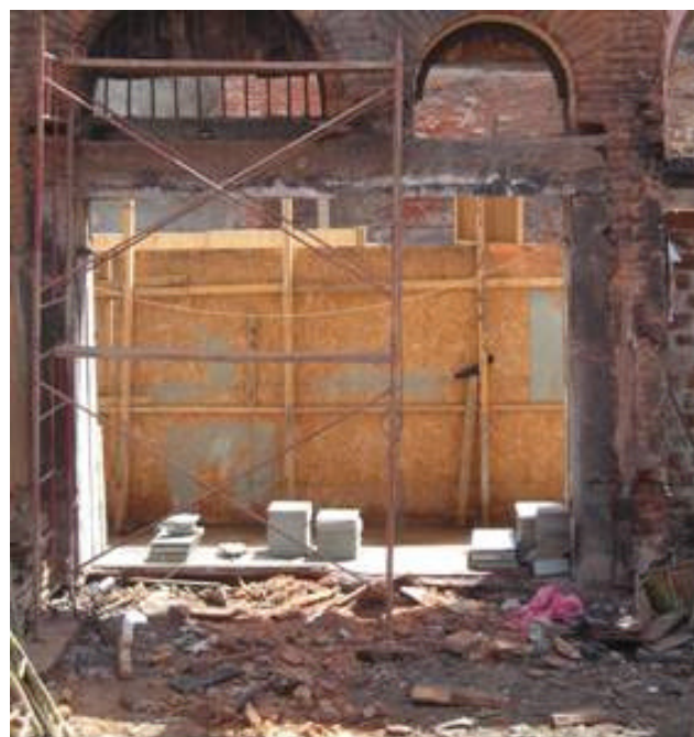
Figura 6.43 – Modificación abertura de la fachada a calle Serrano
