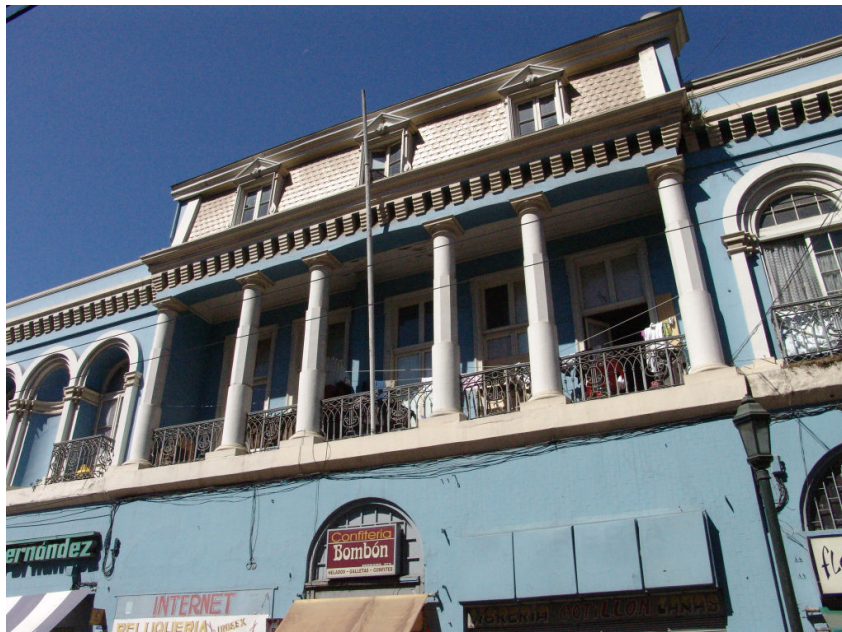
Figura 6.32 - Columnas y mansarda de fachada principal por calle Serrano.
