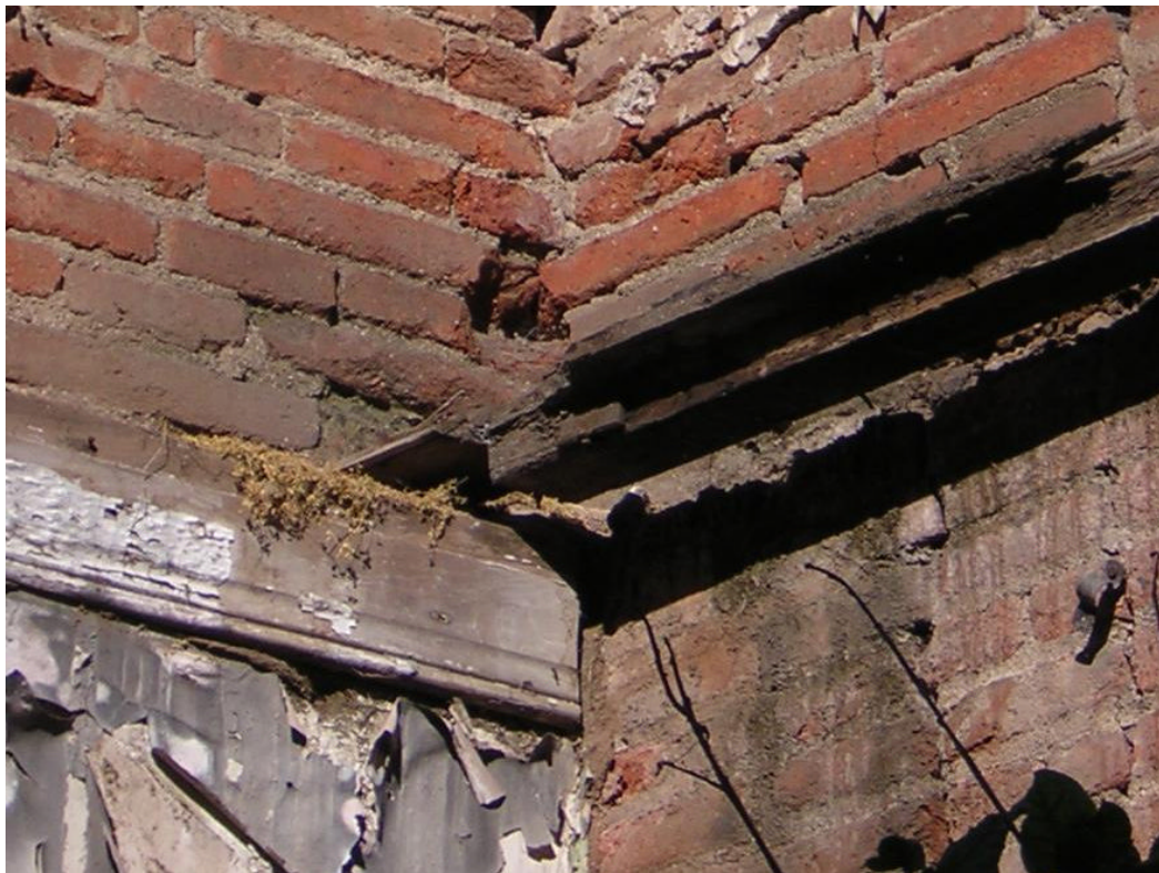
Figura 6.18 - Viga collar en una esquina
