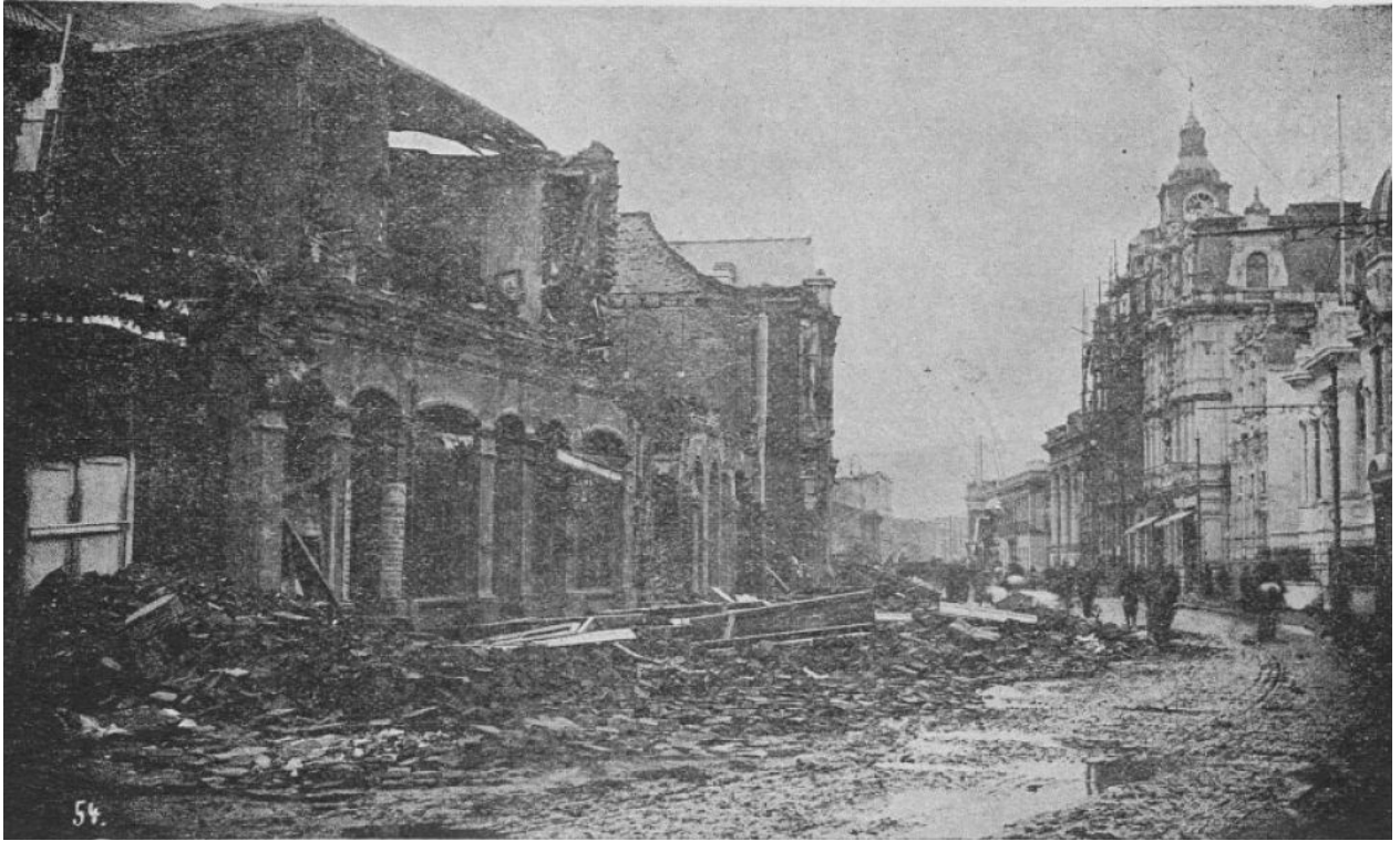
Figura 2.8 – Fachadas derrumbadas de la calle Condell para el terremoto de 1906 (Rodríguez y Gajardo, 1906)
