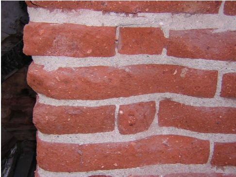
Figura 6.12 - Aparejo de la albañilería a lo largo de los muros
