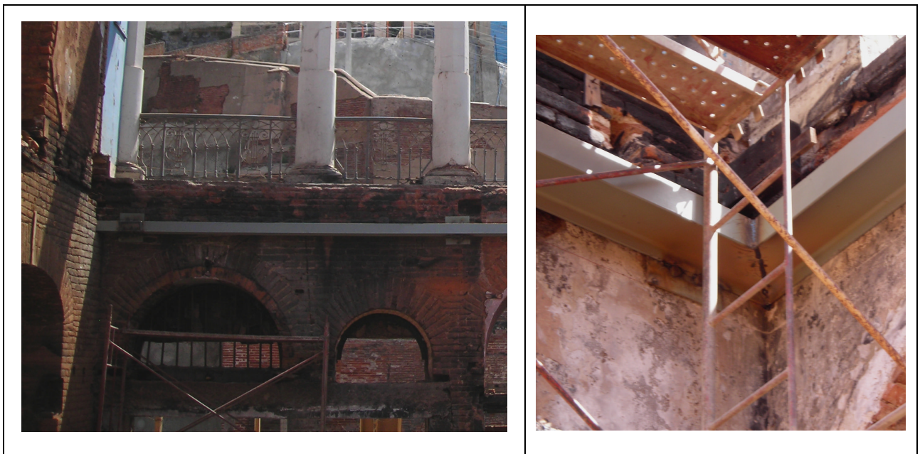
Figura 6.45 – Vista de la viga metálica
