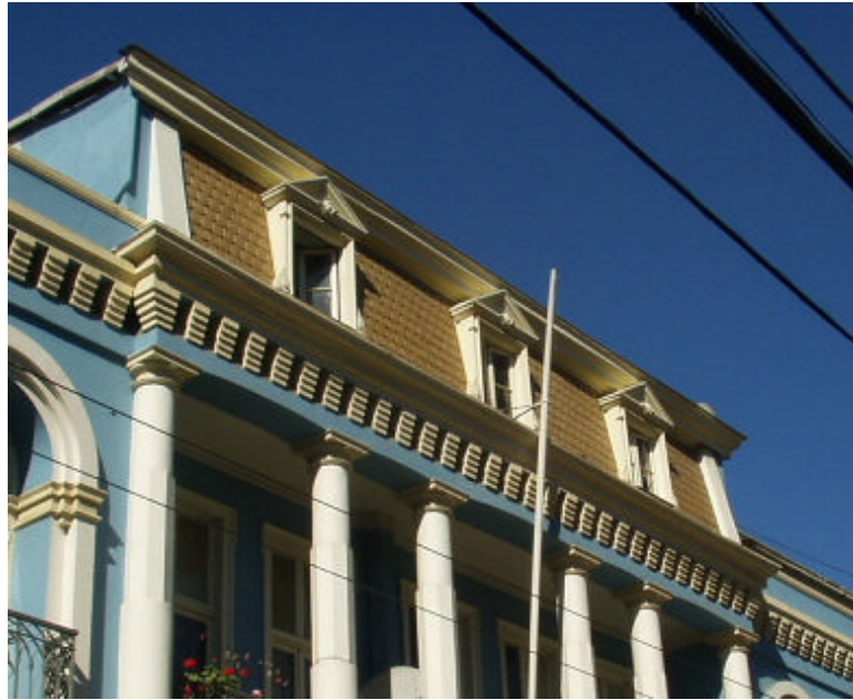
Figura 6.36 - Detalle de capitel de las columnas, antepechos y arcos del 2° piso calle Serrano
