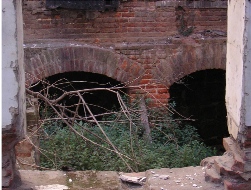
Figura 6.8 – Tabiques interiores adosados a los muros transversales del primer piso
