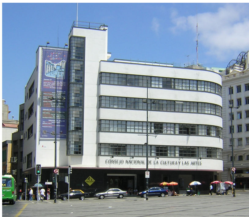
Figura 5.3 – Edificio de hormigón armado
